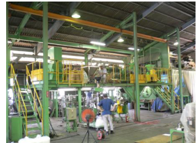
テスト工場内部
