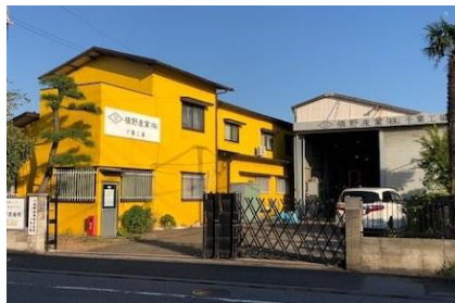
千葉テスト工場外観
