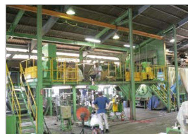
テスト場内部
