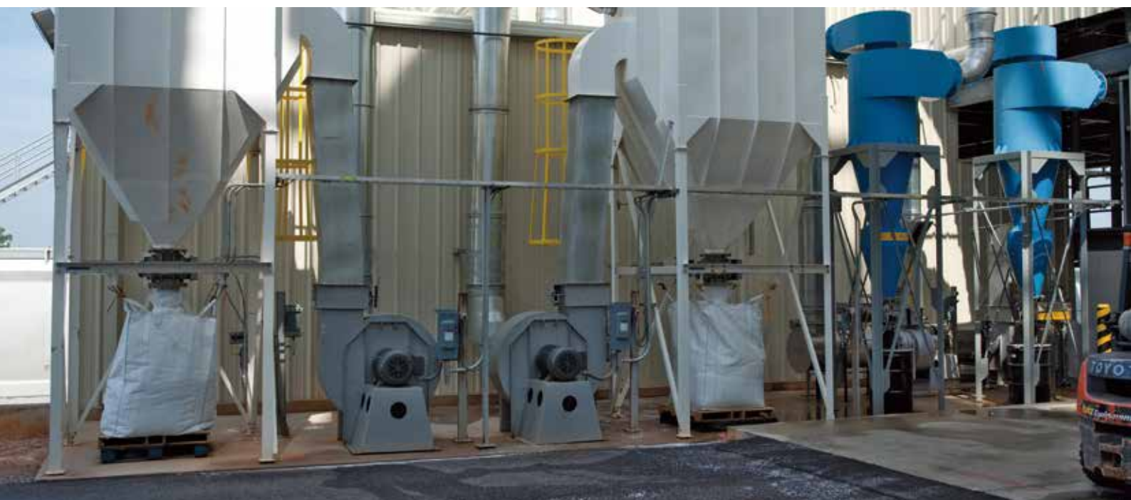
ペレット洗浄装置のファン、バグフィルター、サイクロン
