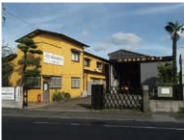
テスト工場外観
