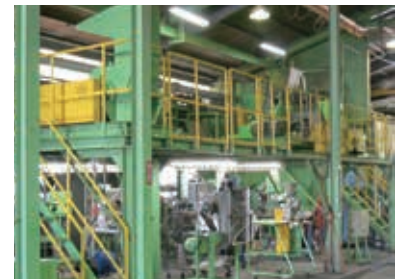
テスト工場内部
