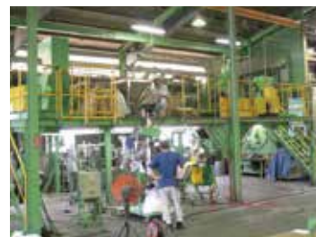
テスト場内部
