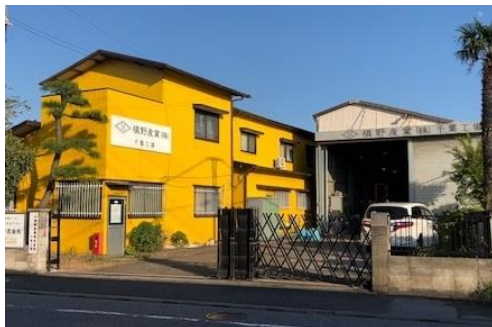
千葉テスト工場外観
