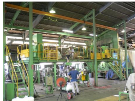
テスト工場内部
